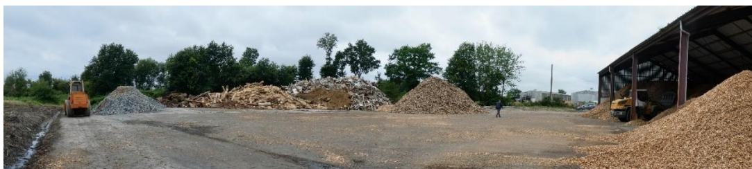
Figure 8. Vue du site partie Nord, 13/07/2021
